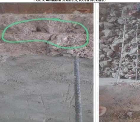
Foto 11: Armadura da escada, após a demolição
