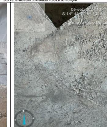
Foto 13: retração excessiva devido à secagem rápida do concreto
