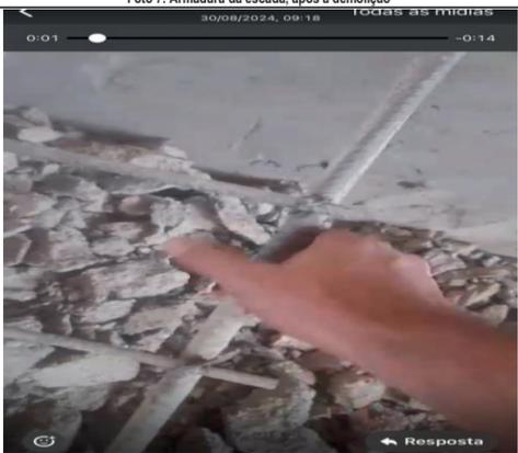
Foto 9: Armadura da escada, após a demolição
