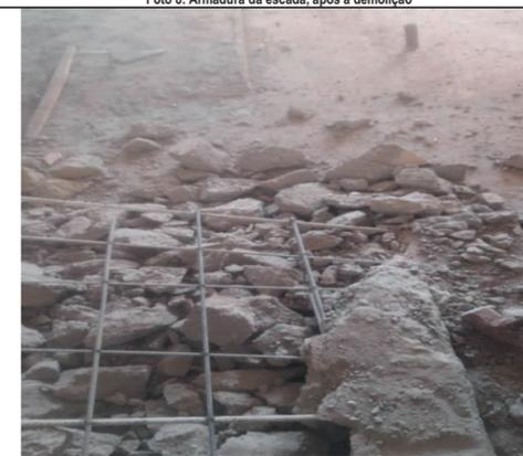
Foto 10: Armadura da escada, após a demolição
