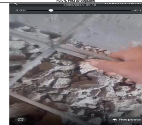
Foto 8: Armadura da escada, após a demolição
