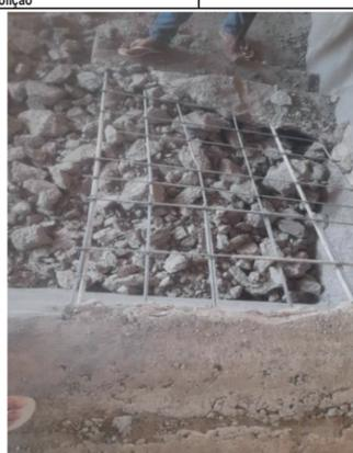
Foto 12: Armadura da escada, após a demolição
