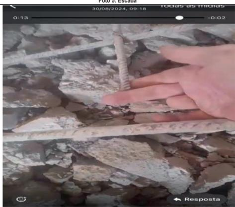
Foto 7: Armadura da escada, após a demolição
