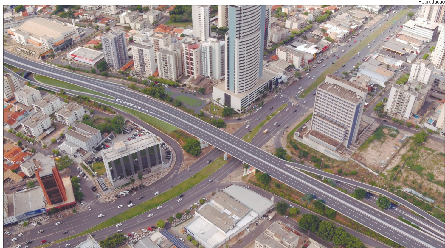
Para a realização da obra, será fechada a rotatória da Rua Boa Vista, na Avenida Miguel Sutil
